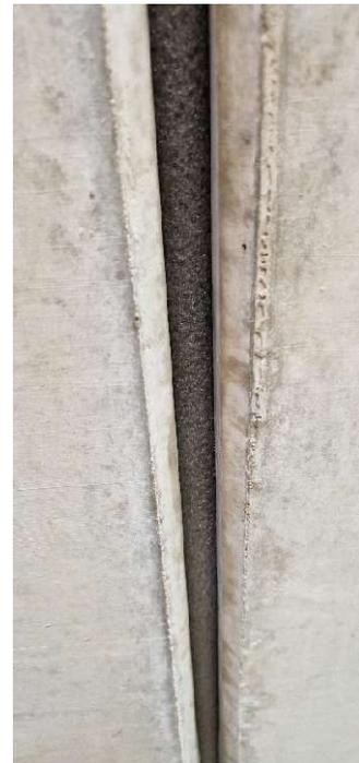
Anschließend mit **jafo-HERMETIC WU Primer** die Betonflanken benetzen
